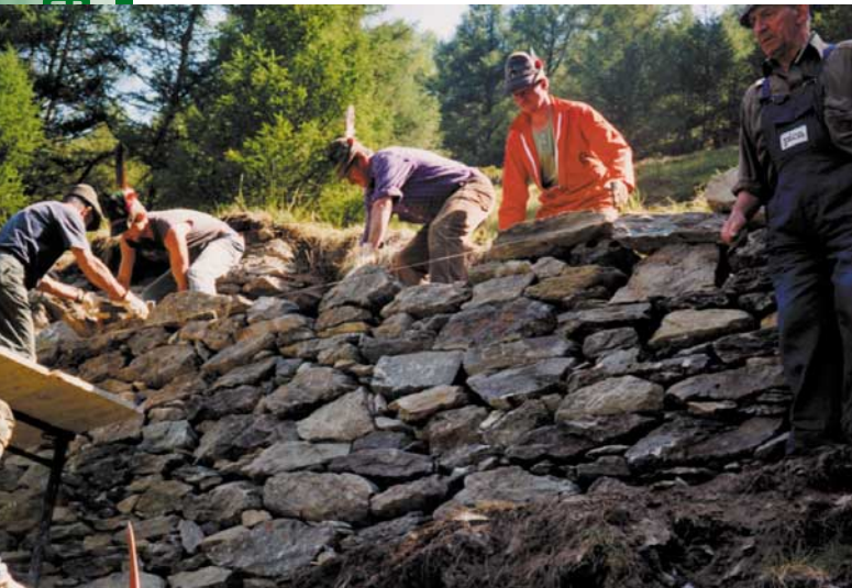
Le penne nere ricostruiscono un muro di contenimento.
